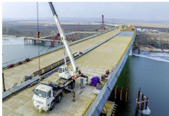
Thi công cải tạo cầu Aksai cũ qua sông Đông (Nga).
