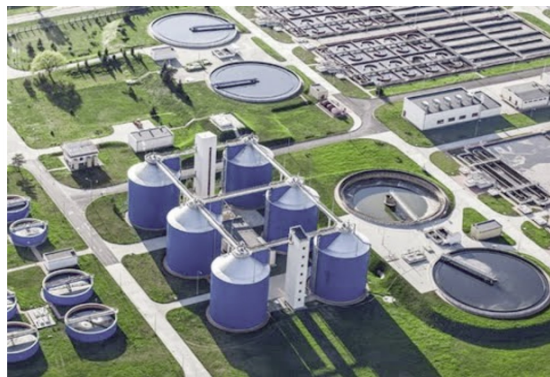
Một nhà máy xử lý nước thải hiện đại tại thành phố Dresden (CHLB Đức).
