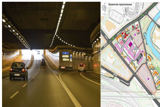
Đường hầm giao thông tại quận Barvikhi, trong khu dân cư đông đúc gần trung tâm Moskva và sông Moskva, áp dụng bê tông tự lèn khi xây dựng.
