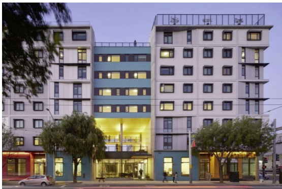
Dự án nhà ở nhiều hộ gia đình Casa Adelante sử dụng cả tấm pin quang điện và máy nước nóng năng lượng mặt trời.
