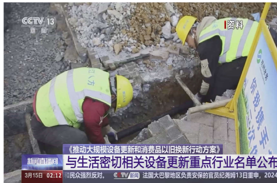
Cải tạo đường ống dẫn khí đốt tại Đát Châu.
