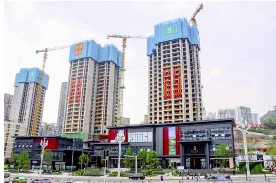
Nâng cấp các công trình xây dựng tại Đạt Châu.
