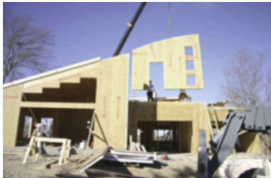
Tấm SIP là vật liệu xây dựng đúc sẵn cực kỳ phổ biến nhờ tác động tích cực của chúng đến hiệu quả năng lượng của dự án.
