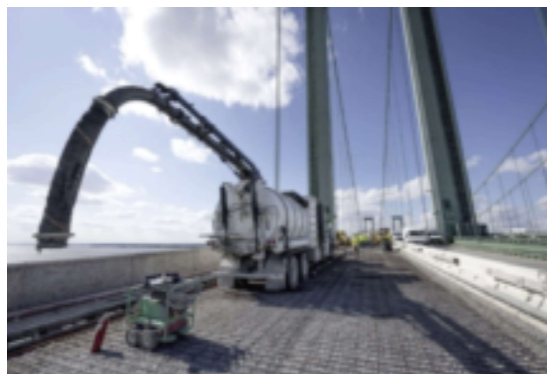
Thi công sửa chữa cầu.
